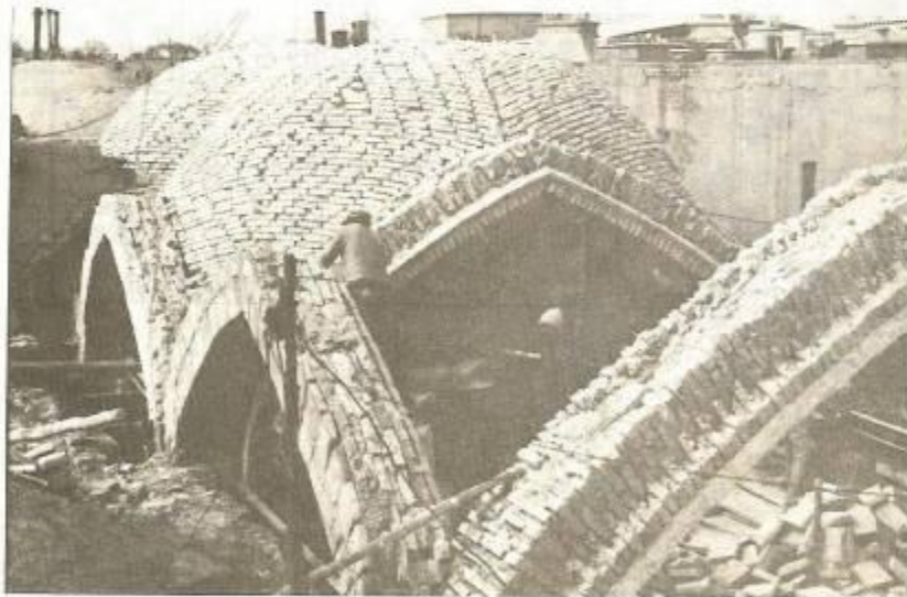
عکس شماره ۱۵ - بازار اصفهان - اجرای ضربی و رومی با هم در ساخت تویزه (عکس از شادروان اصغر رضوی زاده)
