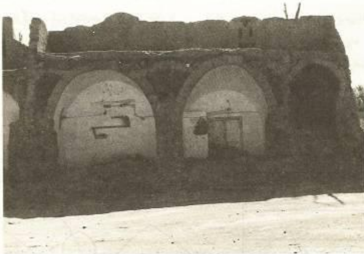
عکس شماره ۳۱- یکی از روستاهای فضل آباد بین راه بم به زاهدان - ترماشور یک نوع کنومازی که در اینجا کنو در همان جهت طاق اصلی زده شده است (عکس از مهندس مهریار)
