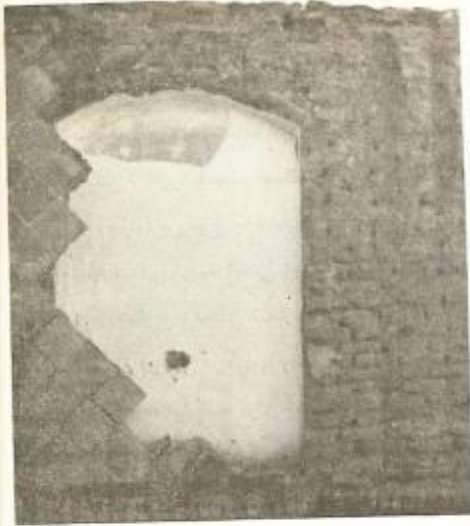
عکس شماره ۳۸ - خانه‌ای در سبزوار پوشش درگاه بصورت چپله است (عکس از علی الداغی)
