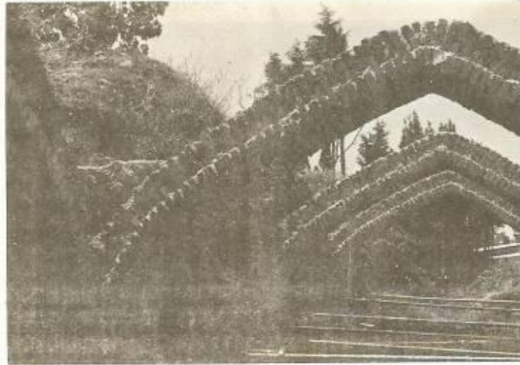
عکس شماره ۱۱- مجموعه فرج آباد سازی- ساختن تویزه (عکس از رضا نصیری)
