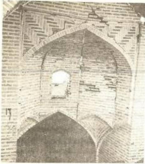
عکس شماره ۴۱- آب آبتاری در یزد استفاده از چند غلط و شکست آن در ناحیه ایوان گاه
