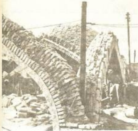
عکس شماره ۴۰- ساختن تویزه (عکس از شادروان اصغر رضوی زاده)
