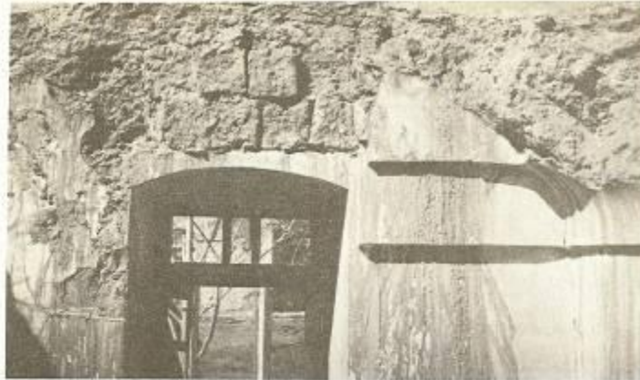
عکس شماره ۱۳ - خانه‌ای در سیزوار - پوشش درگاه بصورت چپله است (عکس از علی الداغی)
