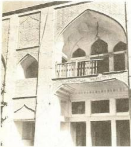
عکس شماره ۴۳- خانه داوید اصفهان شکست در گاه بالائی بعثت استفاده از کشیل در دهانه پائین
