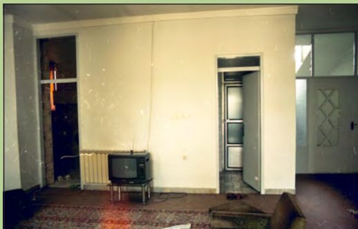
انتقال سرویس های بهداشتی به فضاهای داخلی خانه، در سرویس بهداشتی به نشیمن گشوده می شود - رشت
